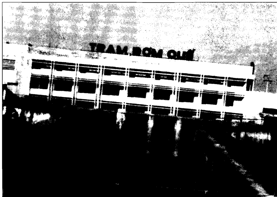
Trạm bơm trục đứng Quế, khánh thành năm 1993.
